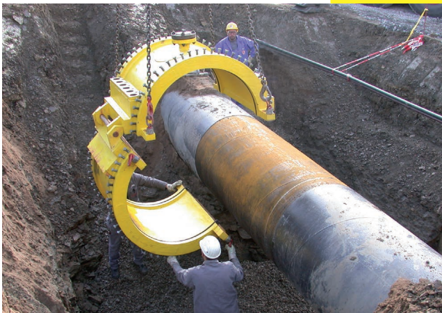
Montage eines Reparaturüberwurfes
